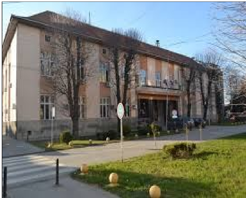
Слика 2. Мерно место бр.1. Ковин - зграда општине
